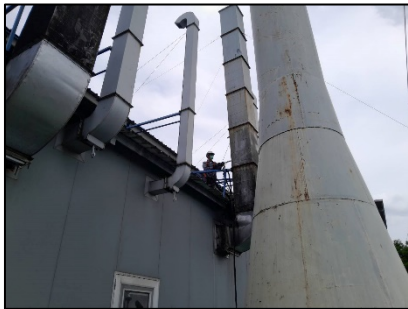
Factory 2 : ปล่องพนัสี No.1
