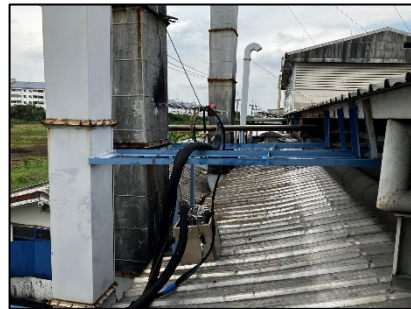
Factory 2 : ปล่องพนัสี No.2
