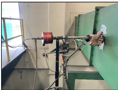
Factory 6 : ปล่องพนัสี No.1
